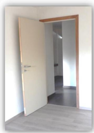
*Les portes intérieures sont à chants plats, de type à peindre. Sur âme tubulaire, paumelles nickelées, poignées en aluminium nature sur rosace, serrure avec clé. Joint acoustique ancré sur toute la longueur du listel.*
